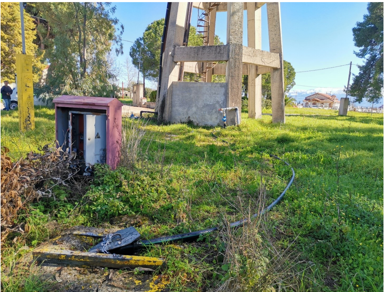
Φωτό 8: Τοποθέτηση του αγωγού εμπλουτισμού μεταξύ υδροληψίας και γεώτρησης TE-1
