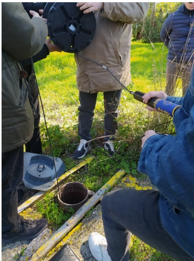
Φωτό 2: Εγκατάσταση συστήματος υδρογεωλογικών παραμέτρων στον σταθμό TE-1 (Νιφοραίικα)
